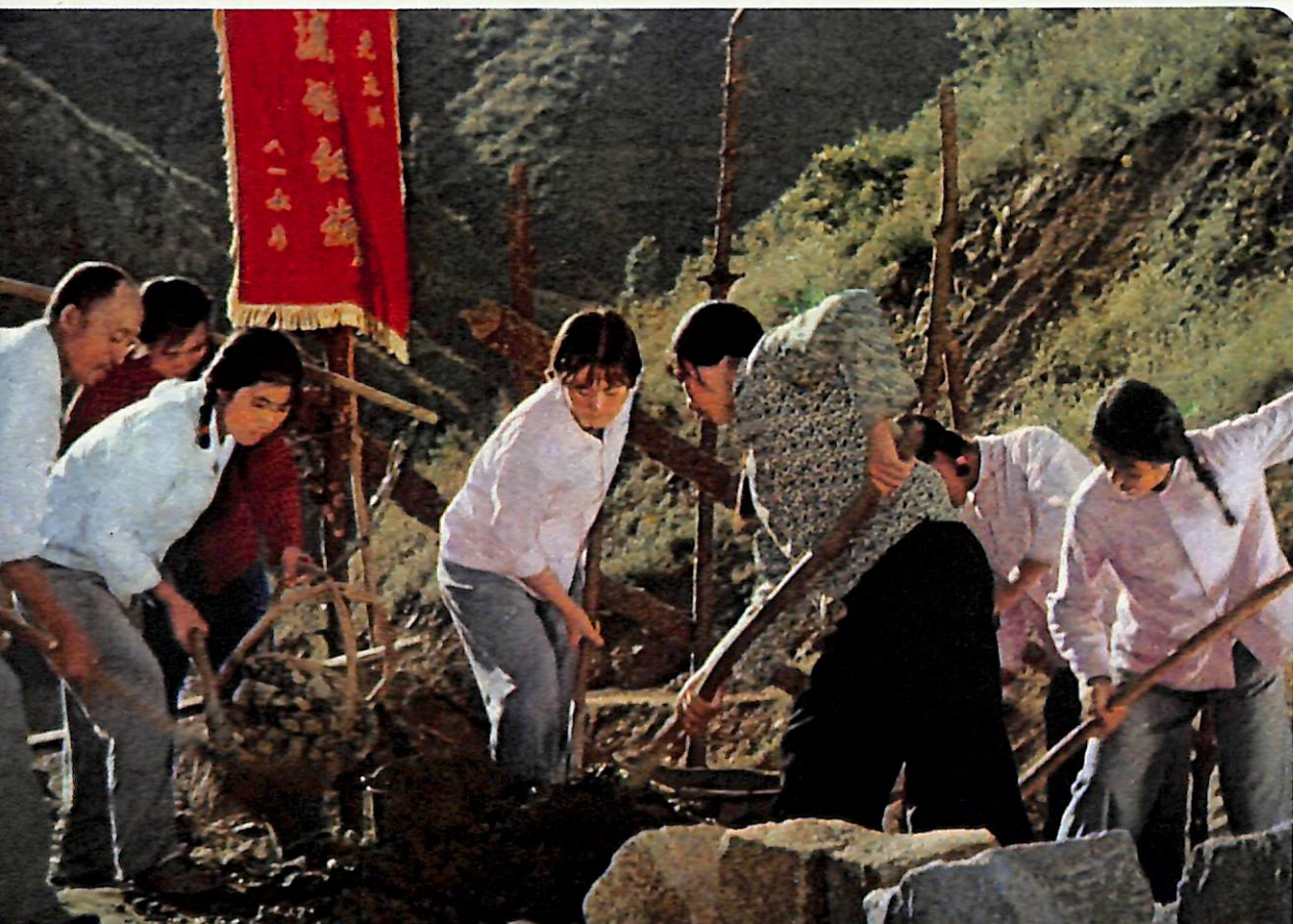
水库工地上，人们在修建大坝。
