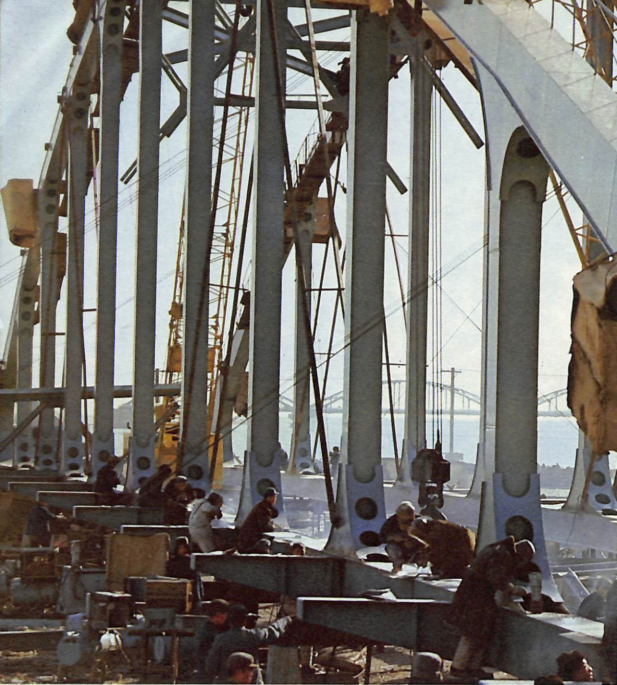
大连港建设十万吨级原油码头，采用了一百米跨度钢桥全部焊接的先进技术。
