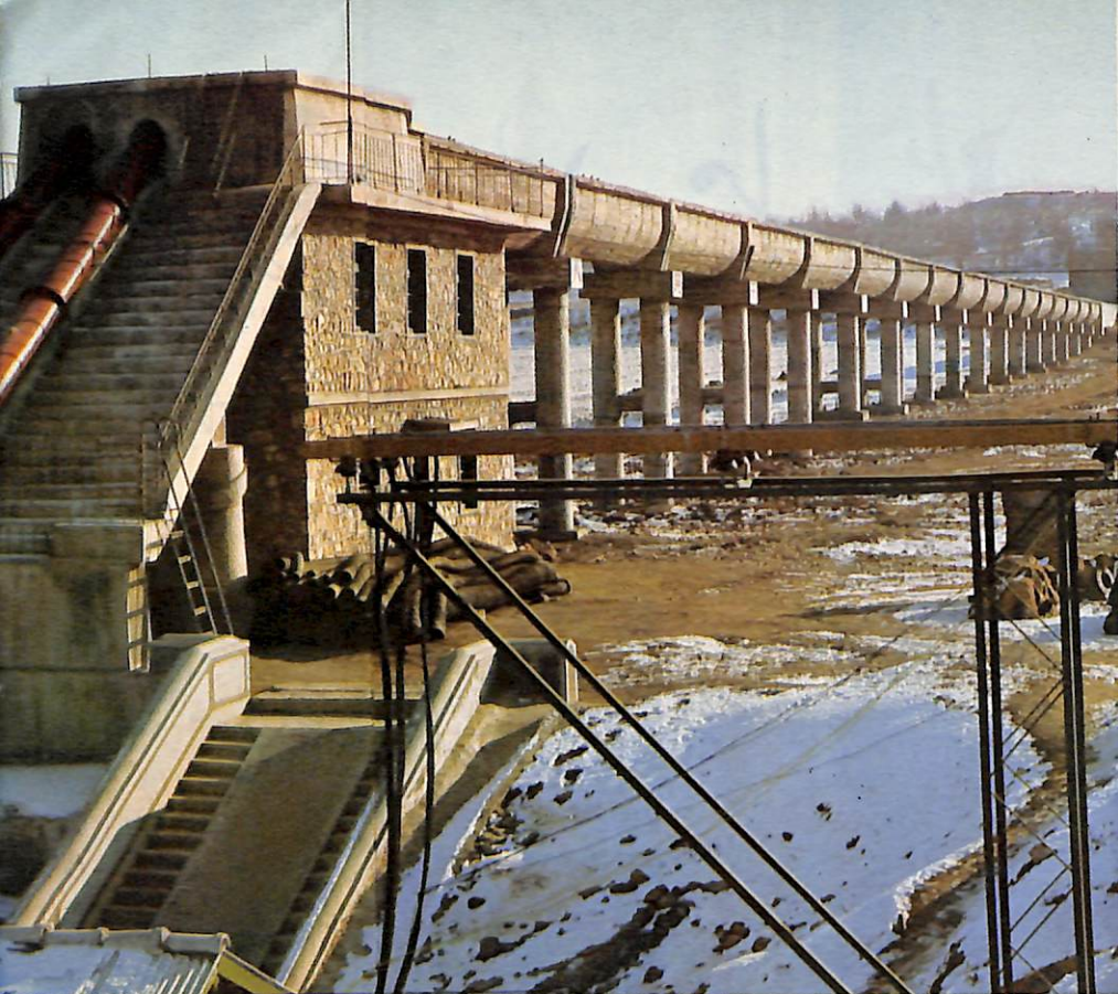
虎庄公社专业队，克服种种困难，修建了三级提水渡槽，引辽河水，能灌溉一万八千亩旱田。
