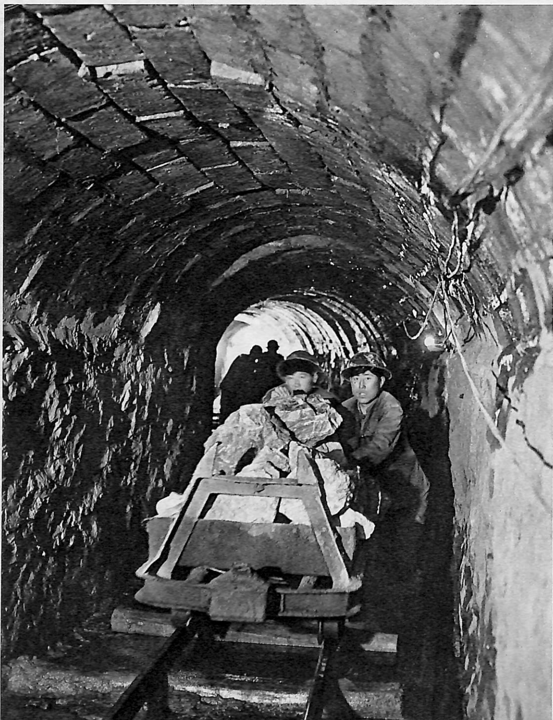
几个公社的专业队联合修建的一个水库的配套工程。
