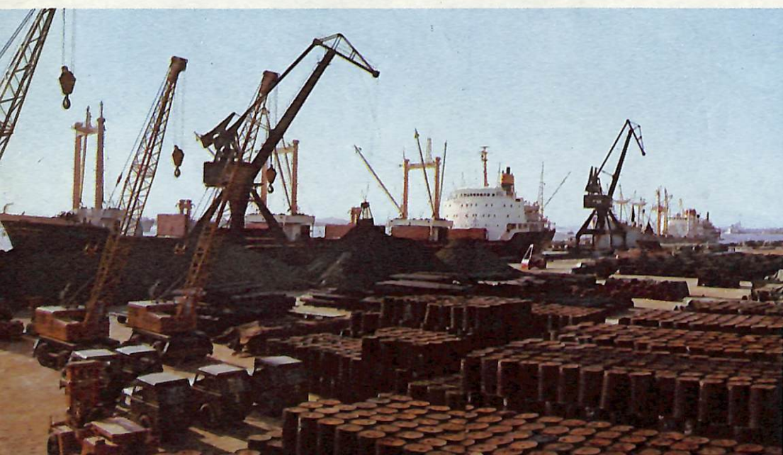
黄埔港新建了六个深水码头，现已投入生产。
