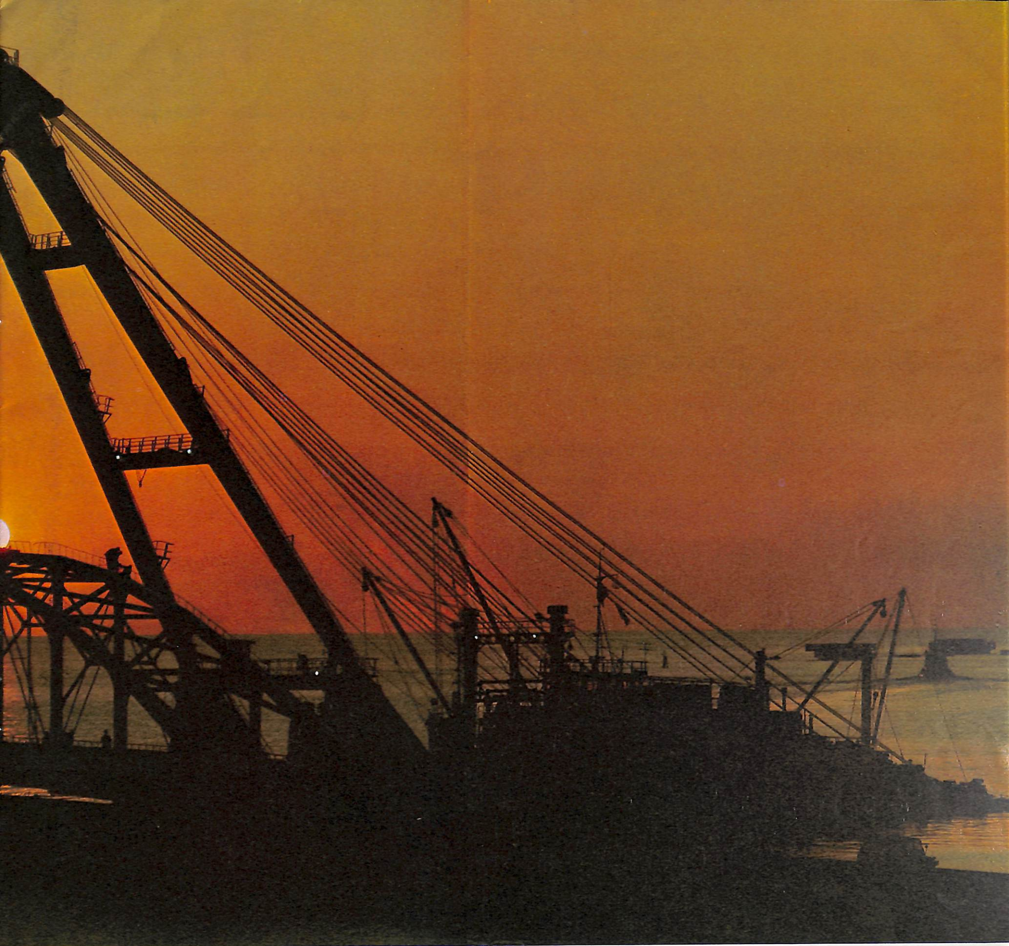
大连建港工人日以继夜地建设十万吨级原油码头。
