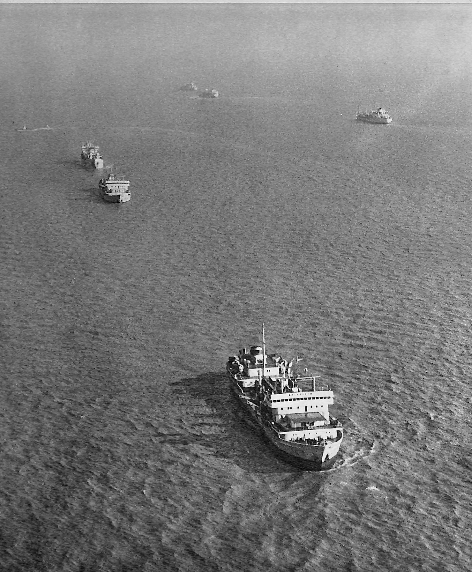
万吨级挖泥船在长江口疏浚航道。
