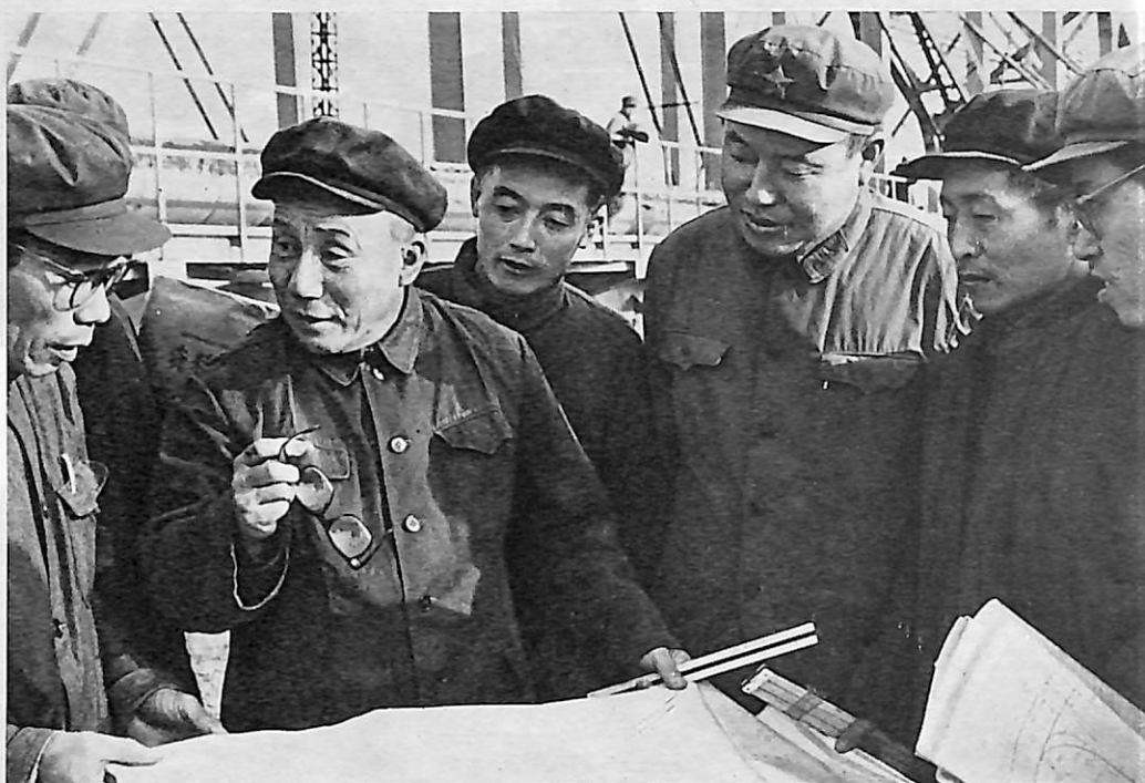
由工人、技术人员、干部组成的三结合技术设计小组在大连原油码头现场进行工作。
