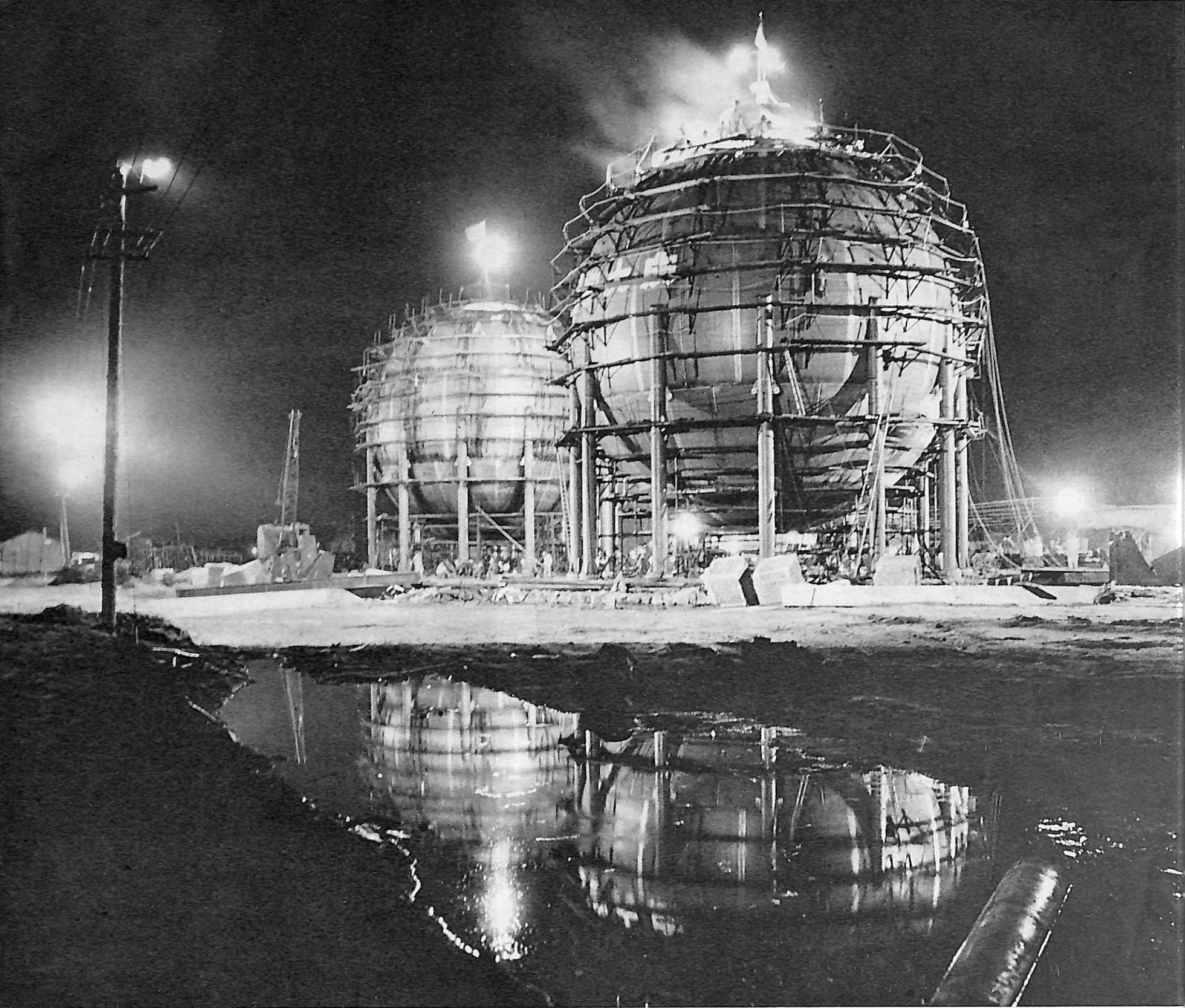
焊工们在短期内就掌握了焊接丙烯腈大球罐的技术。
