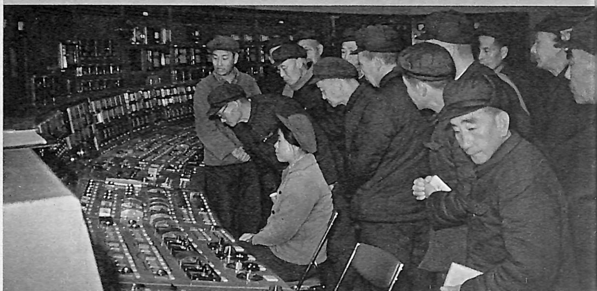
在北京石景山发电厂高井电站一个控制室参观。
