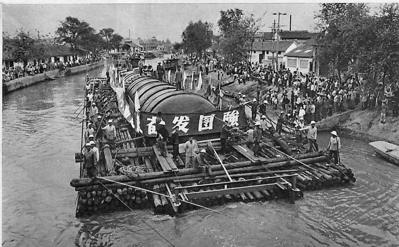
上海市动员各行各业力量加速金山工程的建设。这是扎排工人设法用木排在小河道里运送二百零五吨的大部件。
