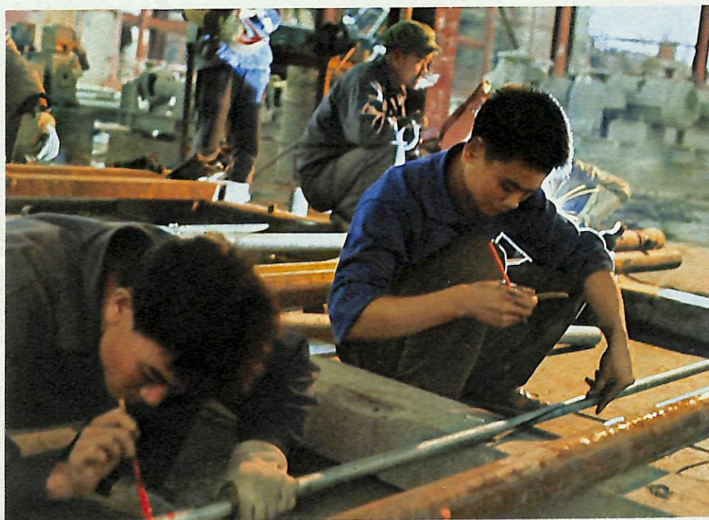
机械工人一丝不苟地安装管道。
