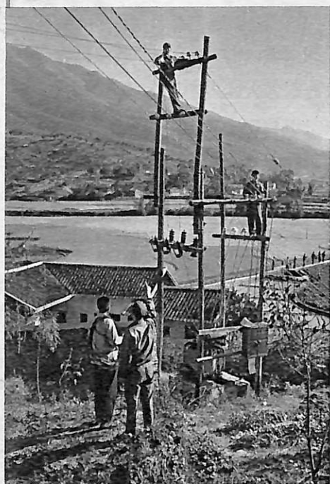
帮助农村水电站架设线路。
