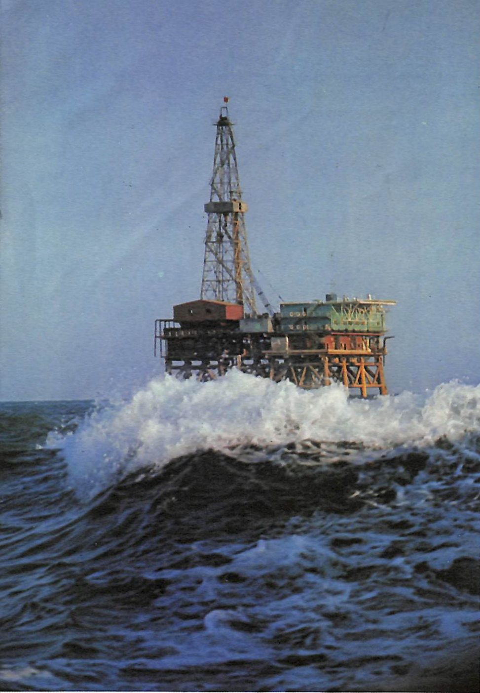
渤海也蕴藏着丰富的石油资源。这是海上石油钻井平台。
