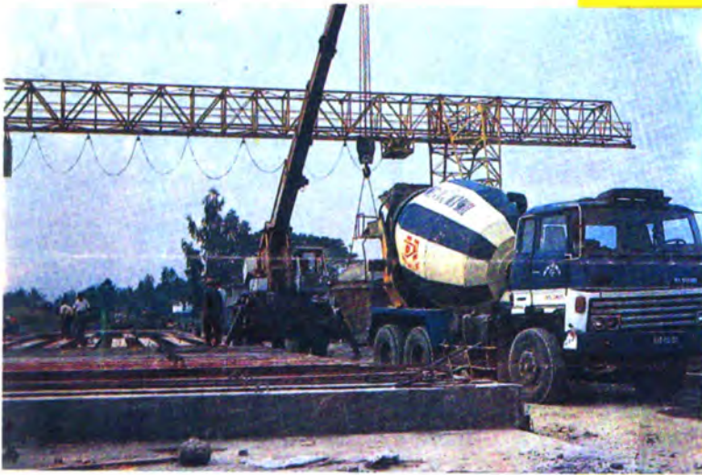
■ Sản xuất cầu kiện bê tông đúc sẵn
