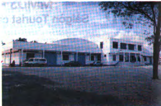
Công trình SHINCHO - VINA (Sông bé)
