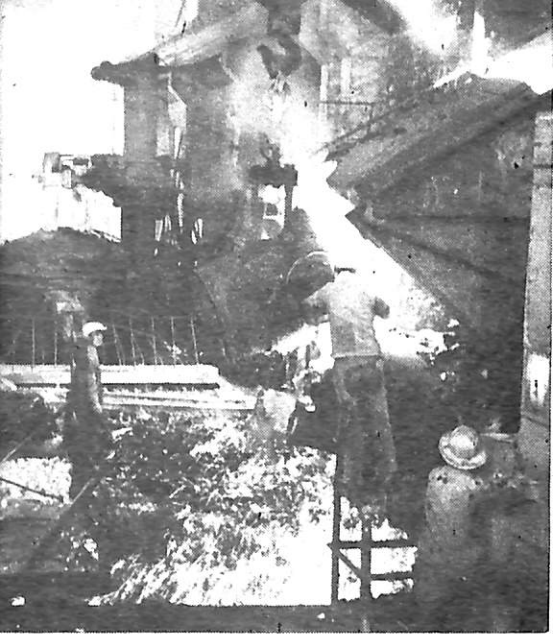
Кипит работа на малогабаритном конвертере с верхним кислородным дутьем малого металлургического завода (округ Яньтай, провинция Шаньдун).
