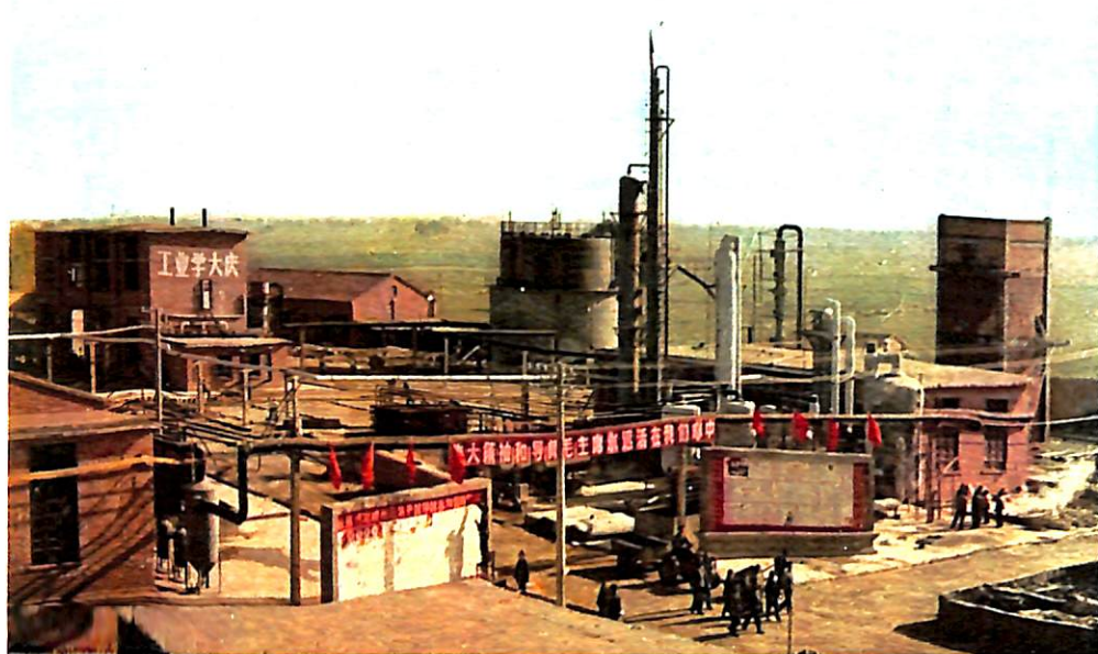
Новопостроенный аммиачный завод при коммуне.
